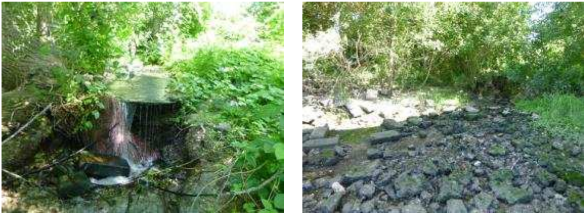
Figure 6. Photographies du rejet de la station d'épuration en haut du talus de berge (à gauche) et de son écoulement sur la berge (à droite).
